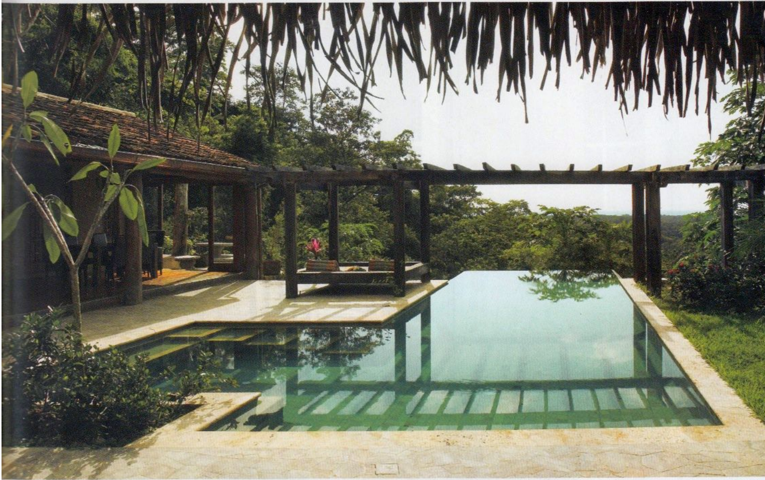
1. Pérgola de madera de melina teñida incolora para darle sombra a la piscina para darle sombra. 2. Las gradas de la piscina y el asiento están remarcados con la piedra natural traída de Turquía. 3. Piscina geométrica con terraza de piedra de mollejón morada y con máquina. El interior de la piscina enchapada con la piedra natural sukabumi de Indonesia. El borde es de la piedra natural crema rosa de
